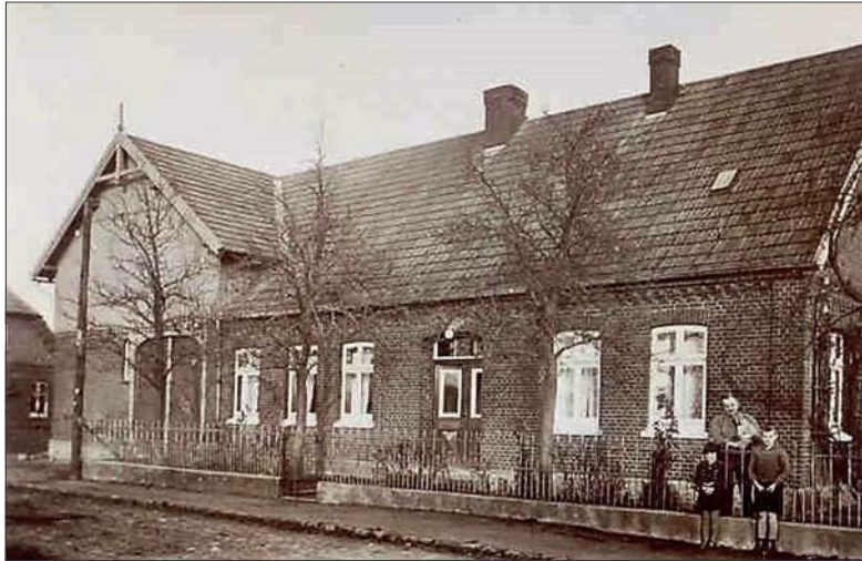
Die Spar- und Darlehnskasse befand sich im Hause der Abbauerstelle Toppenstedt Nr. 46.
