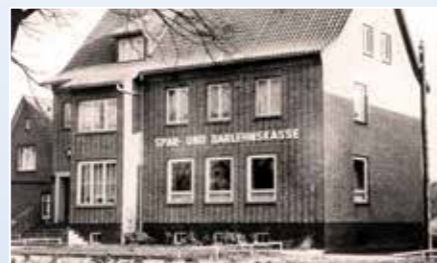
1957 baut die Spadaka Elstorf ein neues Geschäftshaus an der Lindenstraße 2.
