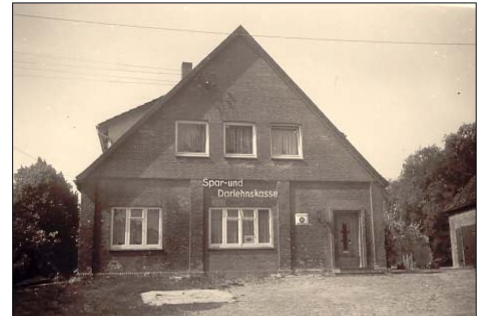
Spar- und Darlehnskasse Jesteburg, Hauptstraße 55 (Foto von 1958).
