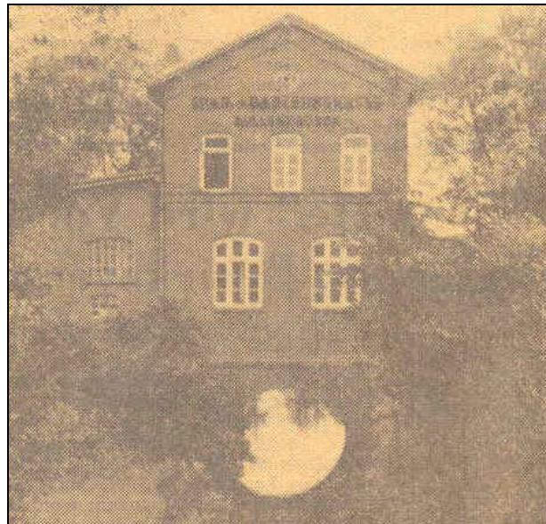
„An der Landesgrenze zwischen Hamburg und Niedersachsen, in dem ehemaligen Schöpfwerk des Schleusenverbandes Bullenhausen, befindet sich jetzt die Zentrale der Spar- und Darlehnskasse“, schreiben die Harburger Anzeigen und Nachrichten in einem Bericht vom zum 75jährigen Jubiläum am 1.12.1961 zu diesem Foto.
