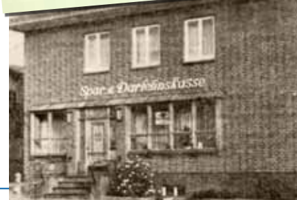
Das erste eigene Gebäude für die Horneburger Spadaka.
