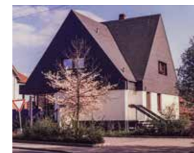
1973 wird das Bankgebäude grundlegend renoviert. Großflächige Fenster lassen viel Licht herein. Die Gardinen leuchten in Orange und liegen damit voll im Modetrend.
