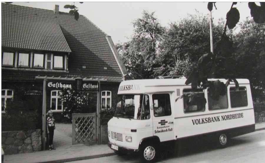
Bankbus vor Aevertmanns Hof, Egestorf-Döhle, in den 1970er Jahren.
